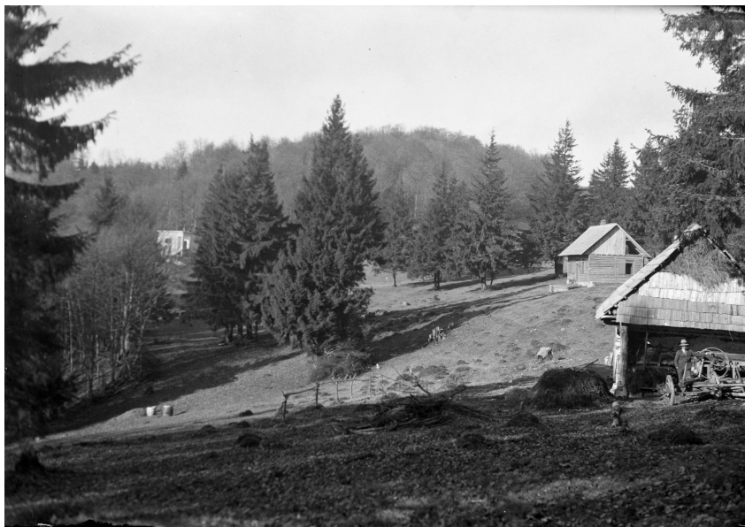
Obr. 13.1: V popredí chata správcu, v ktorej býval aj s rodinou Michal Starinský z Ambrušovce, za ňou nová turistická chata a v pozadí stará kamenná turistická chata (1935). Autor fotografie: Jiří Trejbal. Zdroj fotografie: Archív Pamiatkového úradu SR.
